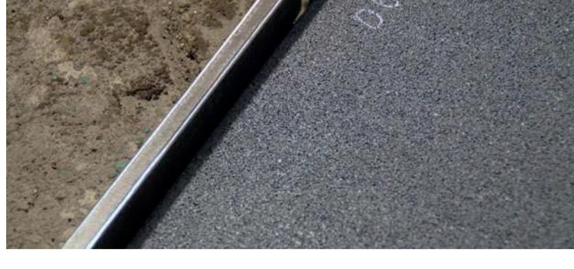
**5** Через 24 часа (при температуре выше 10°C) можно снимать оправку и продолжать монтаж покрытия. Дальнейшая укладка может производиться как с использованием оправки (при необходимости), так и без неё (при минимальном зазоре).
